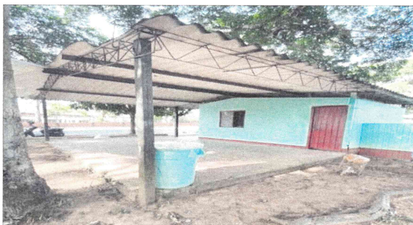
Figura 1.4. Demolición estructura existente Fuente: Documento Técnico Municipio
